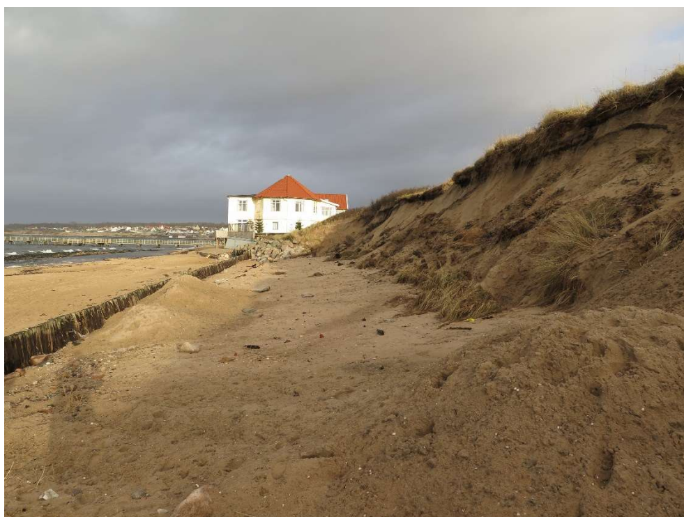
Figur 4. Erosionsutsatt strandnära bebyggelse. Klitterhus, Ängelholms kommun, 2014 (Foto P. Danielsson, SGI)
