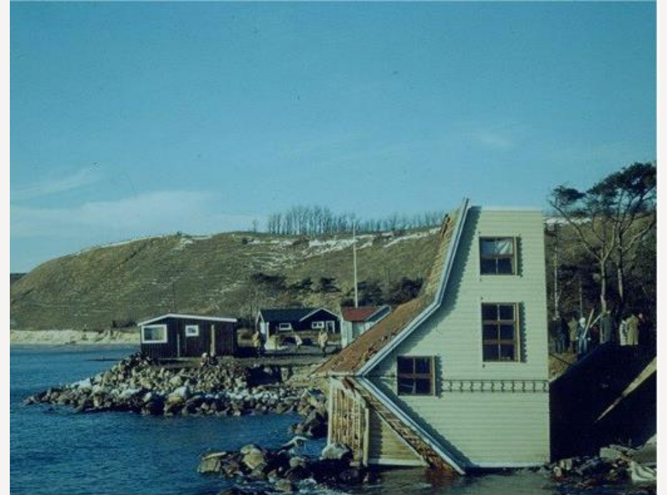
1975 föll det första huset ned i havet till följd av erosionen utmed kusten (fotografi: Löderups Strandbads Villaägareförening).
